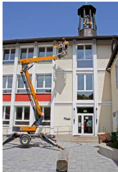
An diesem Schulgebäude werden Mauerseglerkästen angebracht (Foto: Olaf Hettling)
